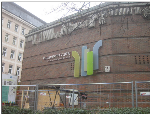
Die TU wird zur Zeit umgebaut
